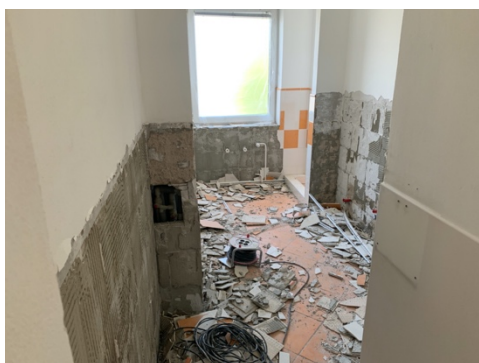
Obrázek 1: rekonstrukce sociálního zařízení
